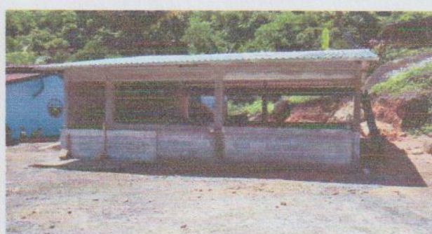
Foto 2: Aula tipo portico con techo de lamina y costaneras.
