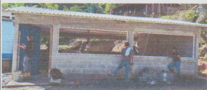
Foto 3: Instalación de puertas y ventanas.
