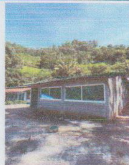
Foto 4: Aula tipo portico con ventanas y puerta instalada.
